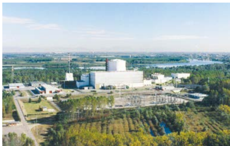
Foto della centrale precedente agli smantellamenti del 2008 (torri di raffreddamento) e del 2010 (edificio off-gas)
