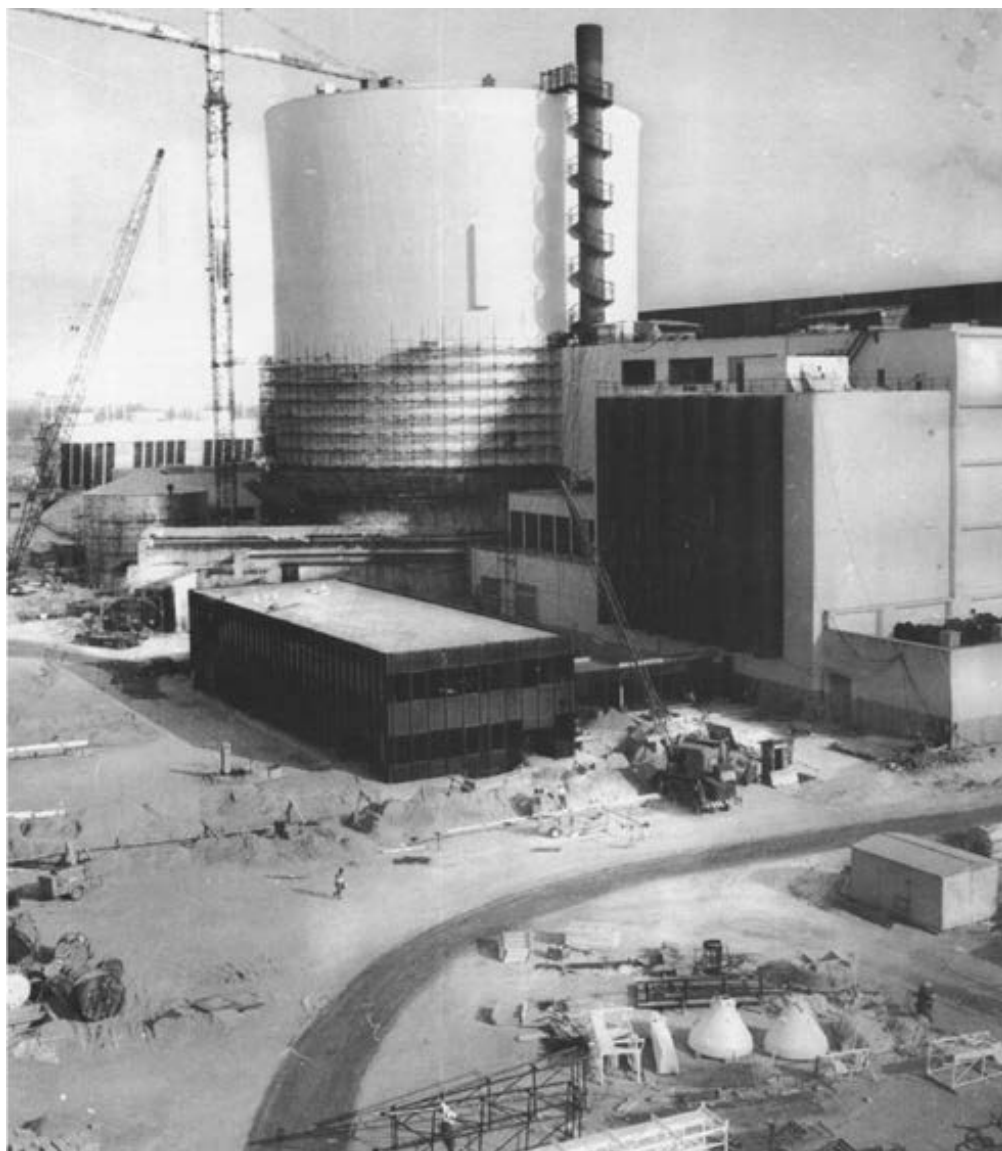
Foto del cantiere della centrale di Caorso
